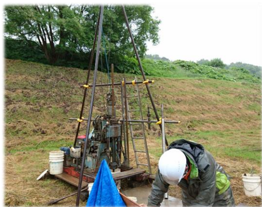
地質調査（ボーリング調査）
