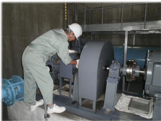
送水ポンプ点検状況
