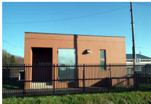
砂川第3分岐施設
