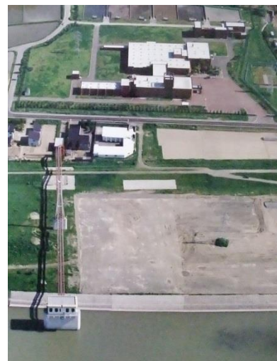
浄水施設全景
