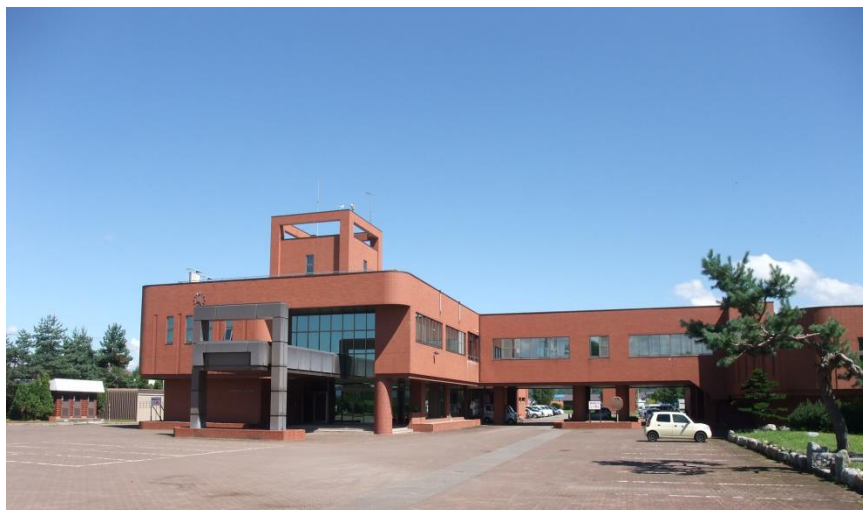
中空知広域水道企業団浄水場
