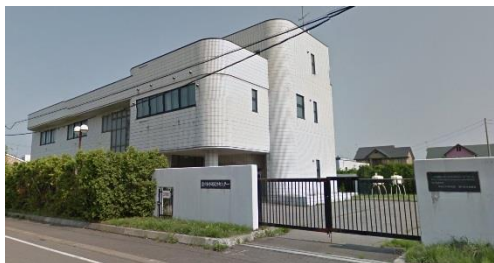
滝川配水センター
