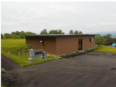
奈井江配水池
